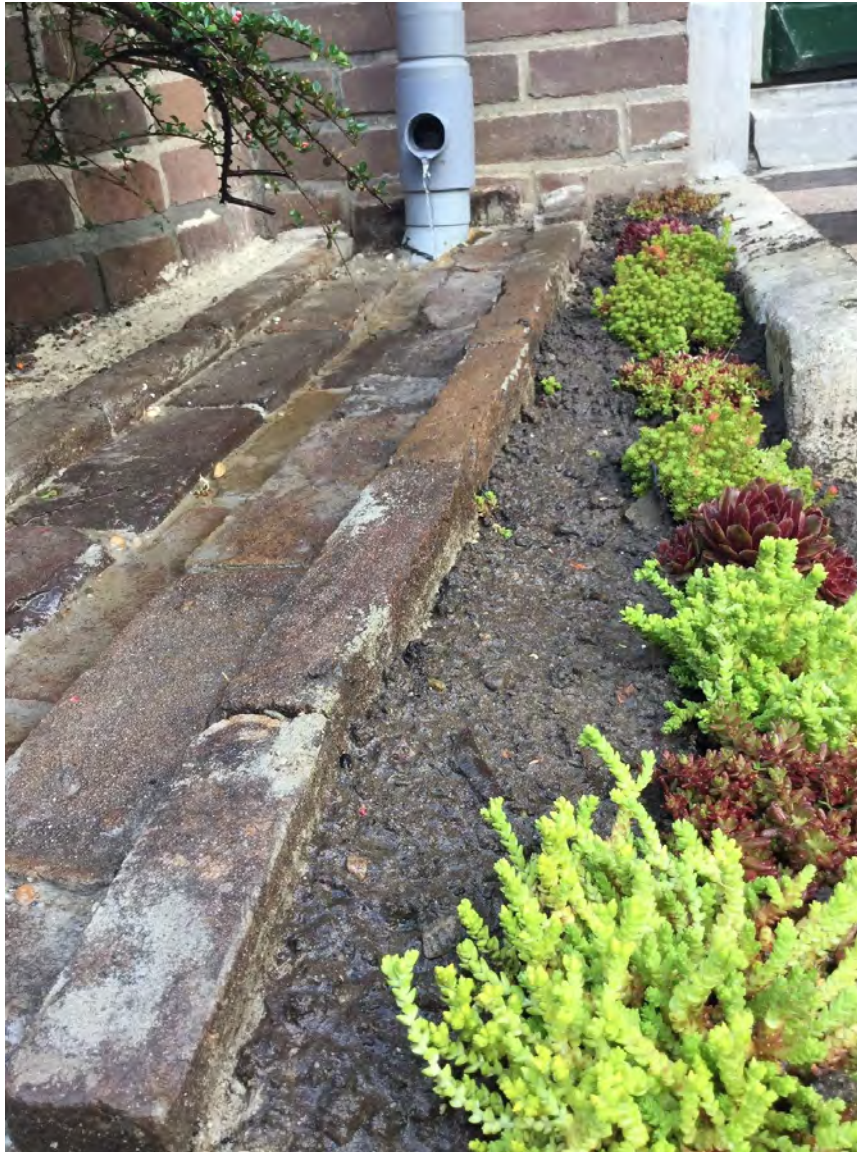
Voorbeeld van afkoppeling van hemelwaterafvoer
