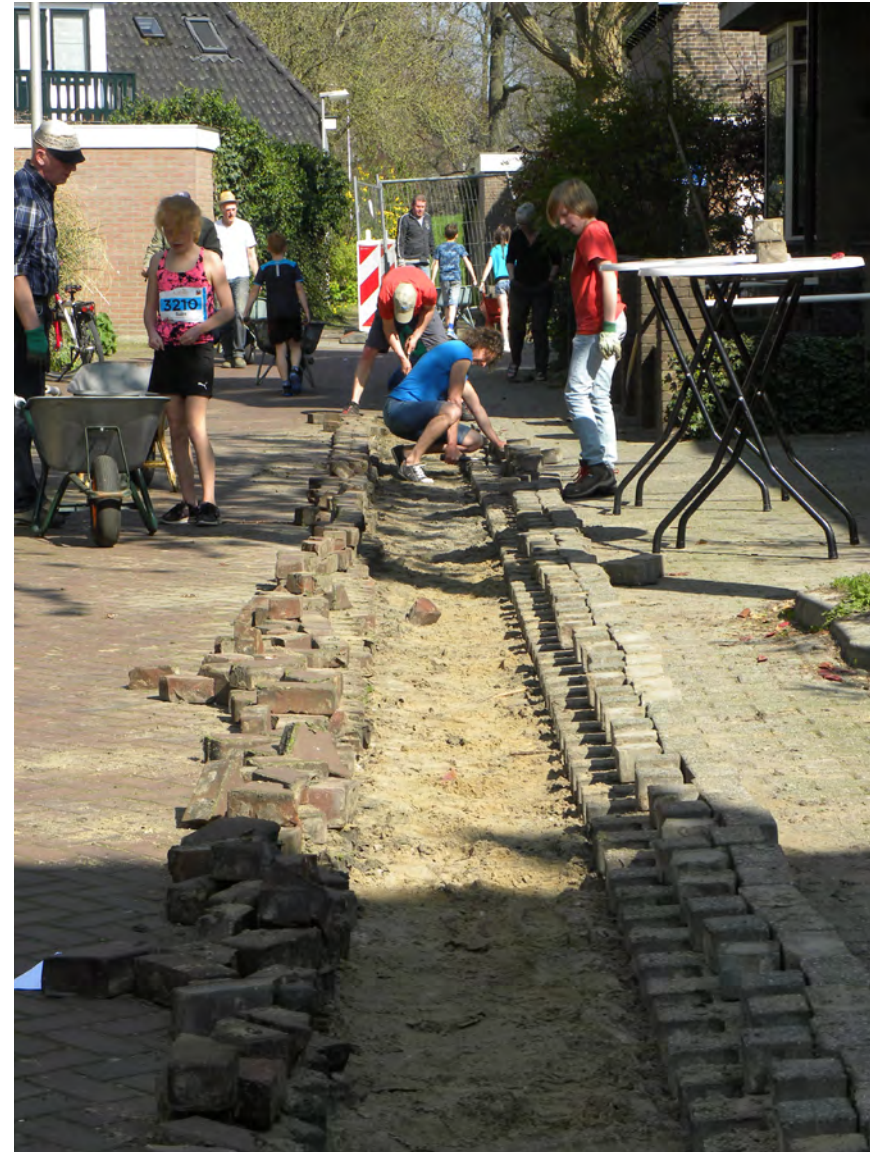
Verwijderen van straatstenen voor Permeoblokken
