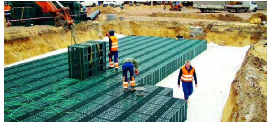
Voorbeeld van de aanleg van infiltratievoorziening met infiltratiekratten
