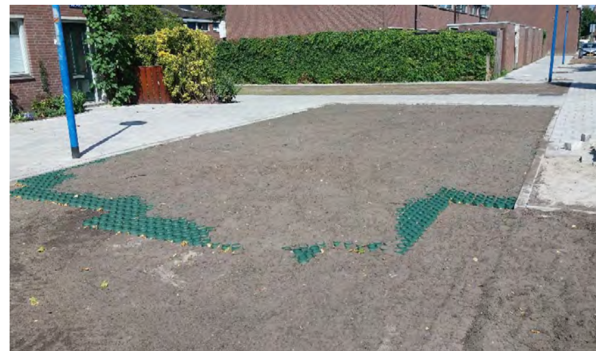
Aanleg van water passerende verharding van grastegels in een calamiteitenroute
