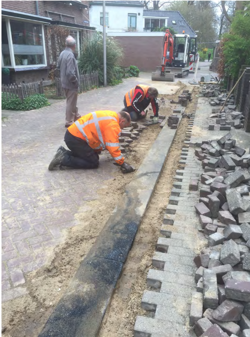
Aanleg van een infiltratievoorziening van Permeoblokken
