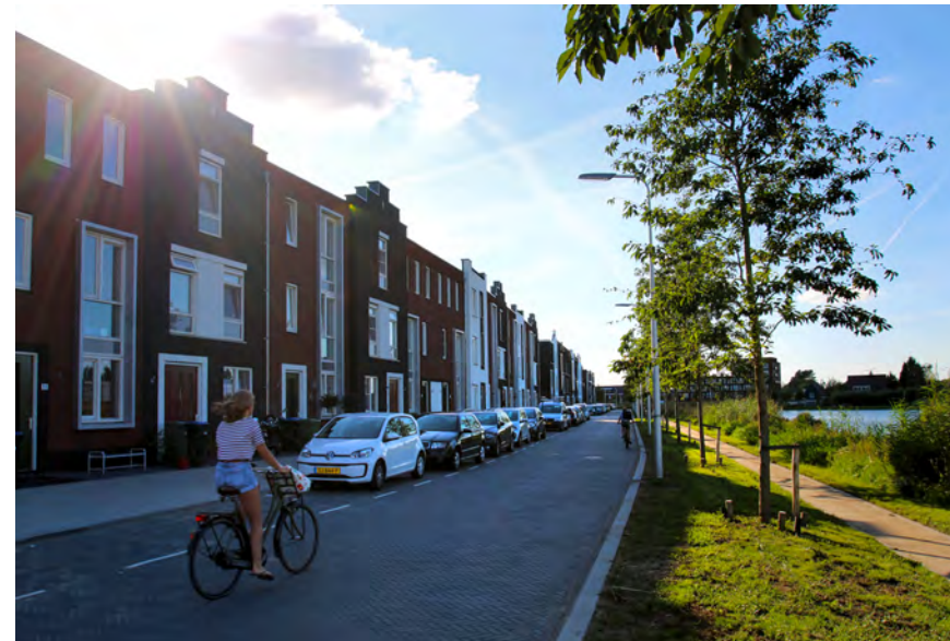
Straat langs een waterbergingsvoorziening
