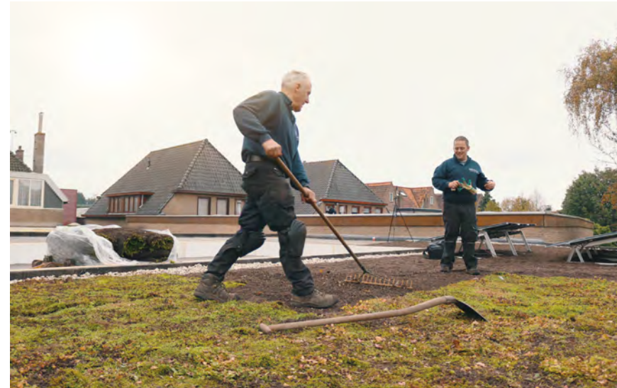
Aanleg van het groendak
