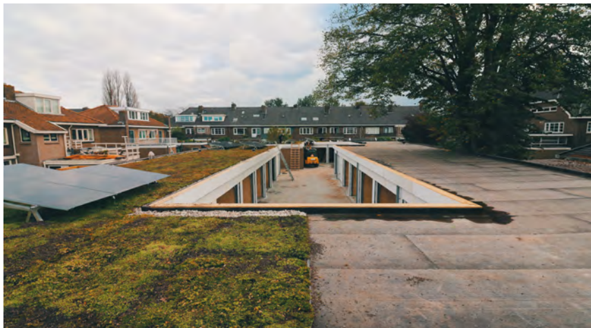
Groendak en zonnepanelen op het dak van de garageboxen
