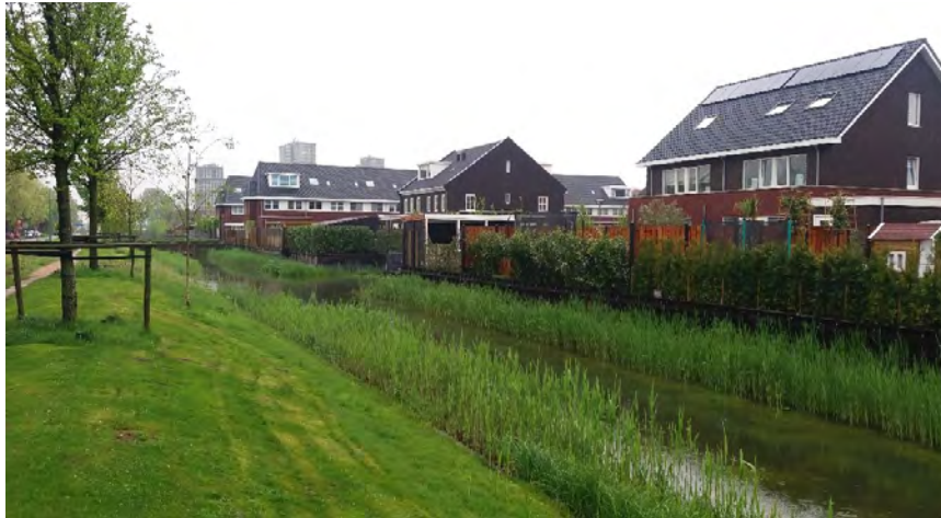
De bestaande Kwartelsingel, gemaakt als hemelwaterbuffer, wordt verder verlengd en verbreed
