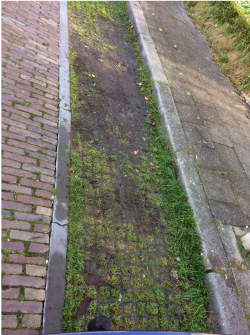
Slijtage van de tegels door het wrikken van autobanden
