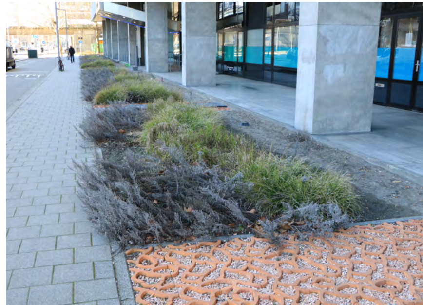
Toepassing van Rain(a)way Flood tegels in een groenstrook
