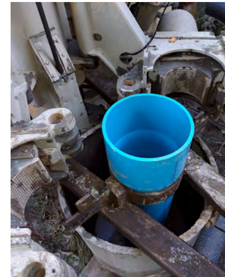
Aanleg van een diepte-infiltratie voorziening
