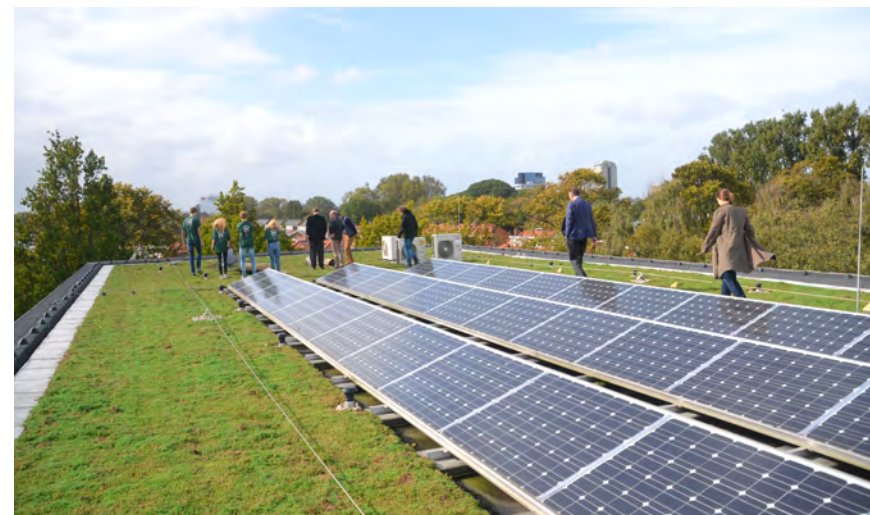
Het groendak met zonnepanelen op het dak van de Daltonschool
