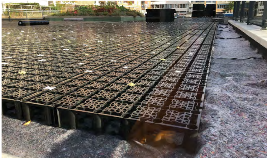
Opbouw van het polderdak op de parkeergarage
