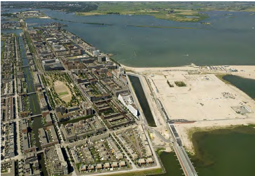
Aanleg van het Centrumeiland
