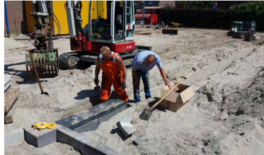
Aanleg van een infiltratievoorziening met Permeoblokken in de Taanshuurpolder
