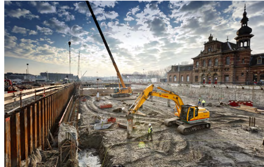
Aanleg van de spoortunnel voor het oude stationsgebouw
