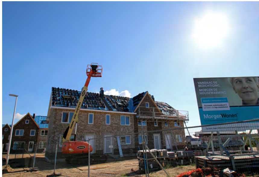
Woningen in aanbouw
