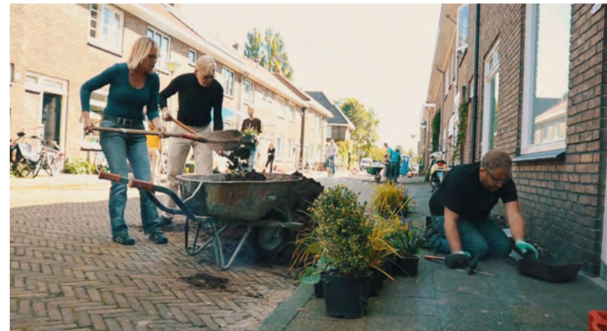
Aanleg van de geveltuintjes in de Seringenstraat
