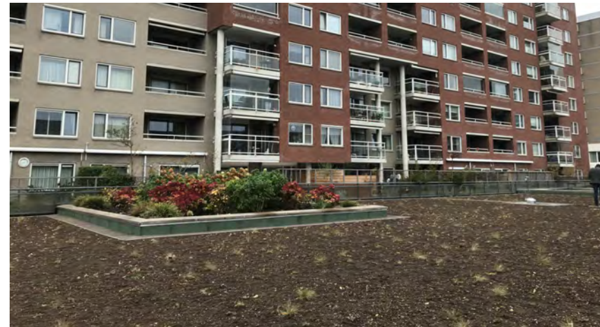
Het polderdak op de parkeergarage net na realisatie. De beplanting kan nu gaan groeien
