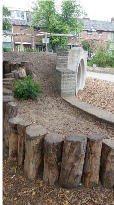
Het vervangen van tegels door groen op een schoolplein, de tegels zijn hergebruikt als speelelement
