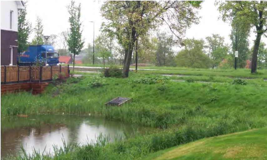
Naast dit inlaatpunt, komt een vergelijkbare constructie voor de overloop
